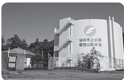
観音山配水池
